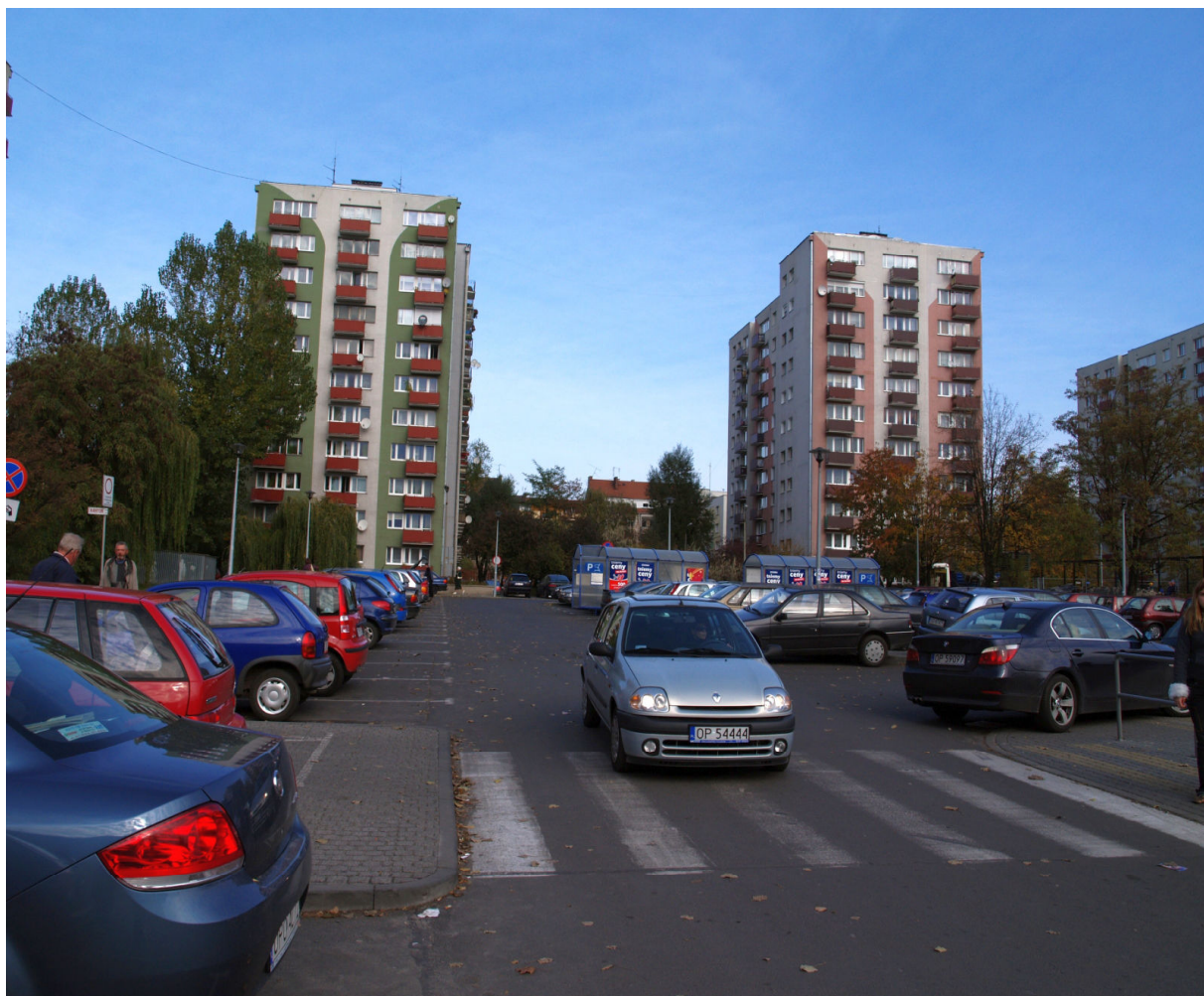
Fot.8 Budynek wielorodzinny
