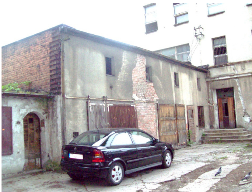
Widok budynku wraz z komórkami od strony elewacji zachodniej (bud. główny) oraz elewacji południowej (komórki gospodarcze).
