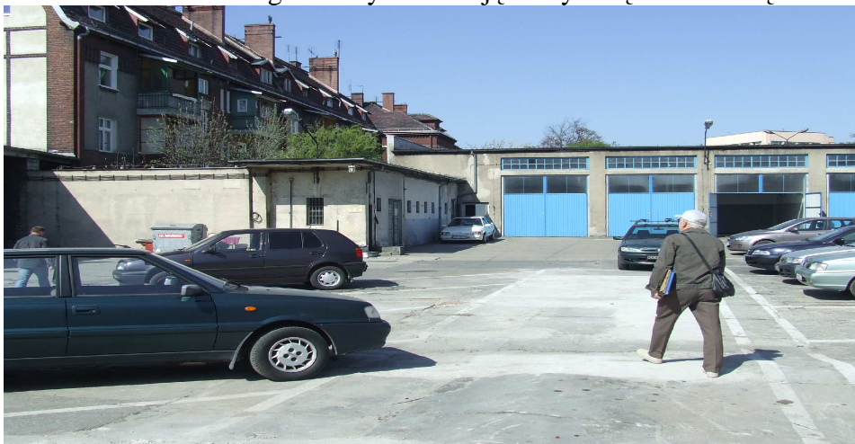
Widok na mur graniczny i elewację szczytową - zachodnią
